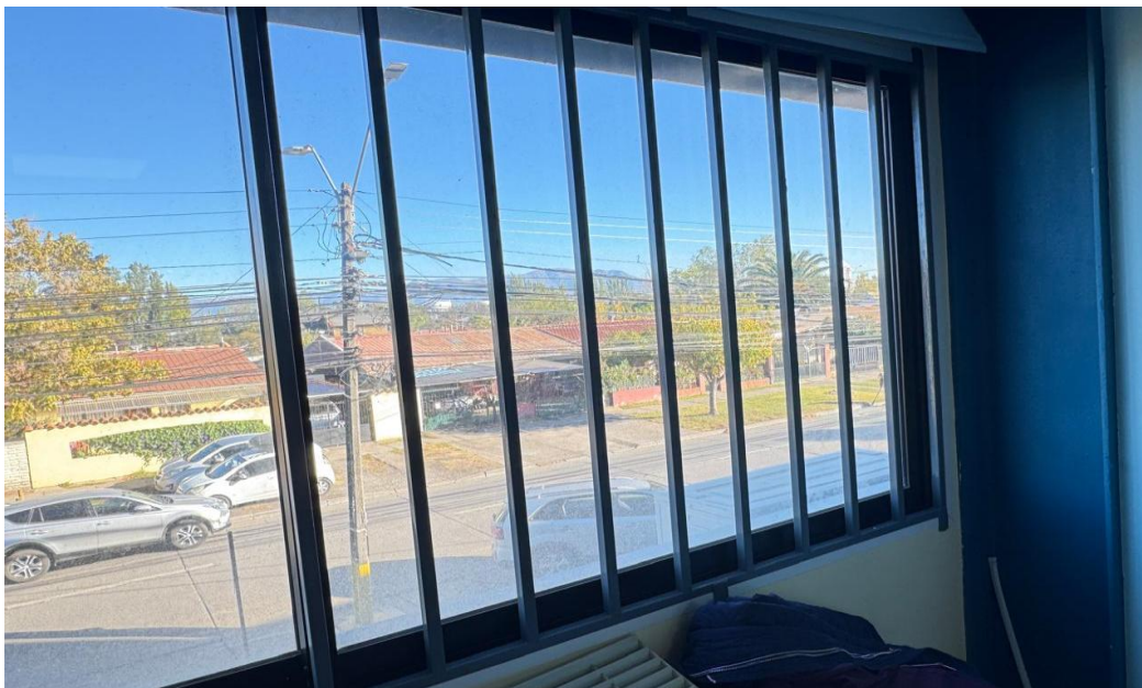
Protecciones ventanas 2° y 3° piso
