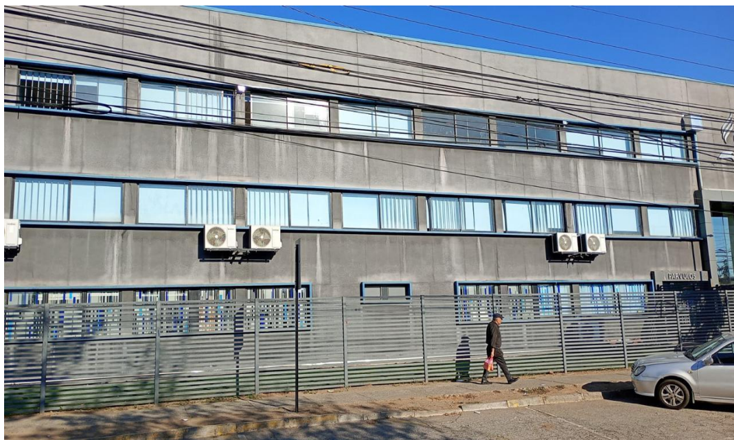
Protecciones ventanas 2° y 3° piso
