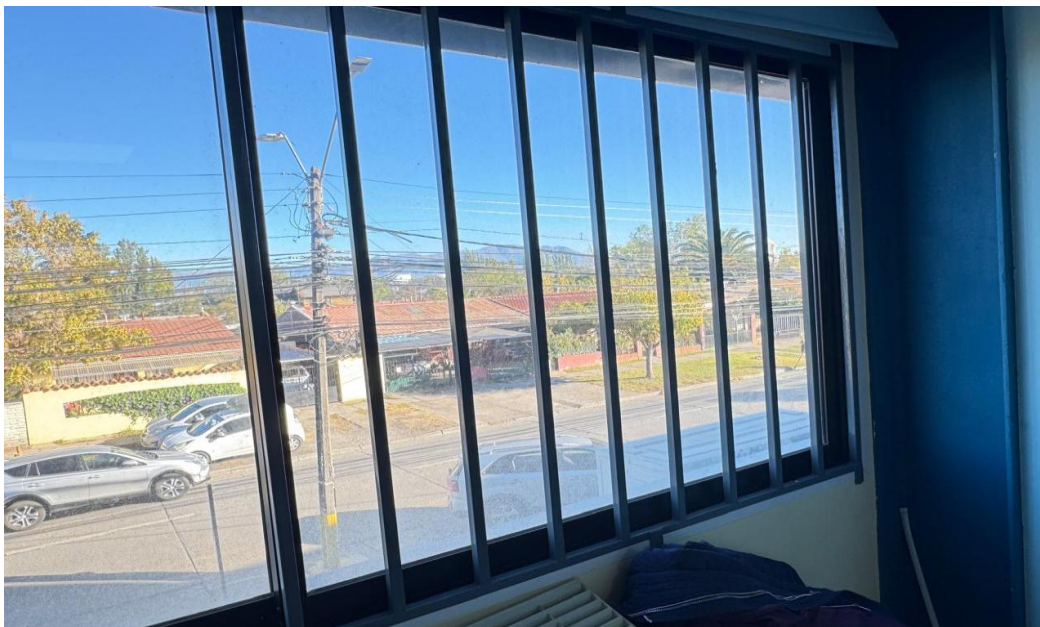
Protecciones ventanas 2° y 3° piso
